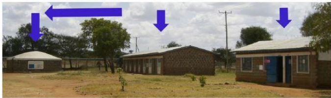
Große Schuldächer fangen in der kurzen Regenzeit das Regenwasser auf und leiten es in den Wassertank.
